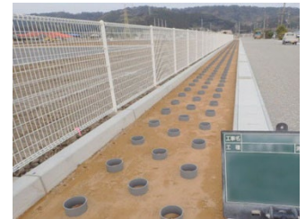
写真-7 施工事例(防草・緑化)
