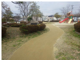
写真-5 施工事例(園路)
