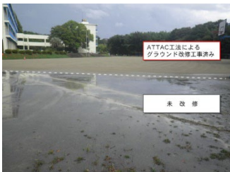
写真-4 施工事例(グラウンド)
